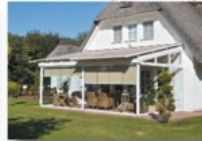
Terrassenüberdachung mit Beschattung
